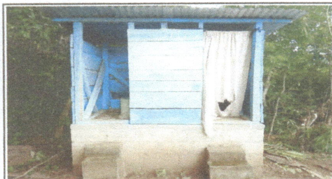
Foto 3: Se observa el deterioro de puertas y gradas del Sanitario.
